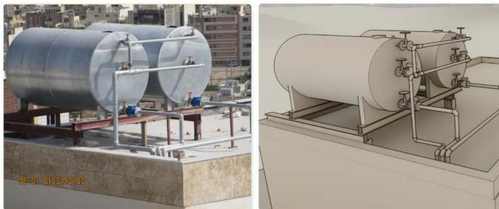
شکل ۴ تولید نقشه‌های اجرایی در رسته تاسیسات مکانیکی با بهره‌گیری از پروژه BIM
